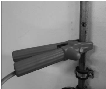
Erdungsklemme an zugelassenen Potentialausgleich (Erdung) anschließen.
